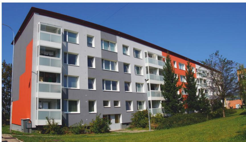
Bytový dům - Větrná č.p. 869-871, Uherské Hradiště - Mařatice
