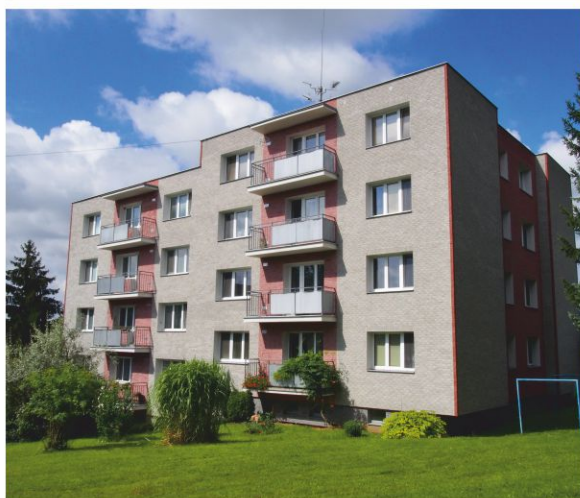
Bytový dům - Buchlovice č.p. 561
