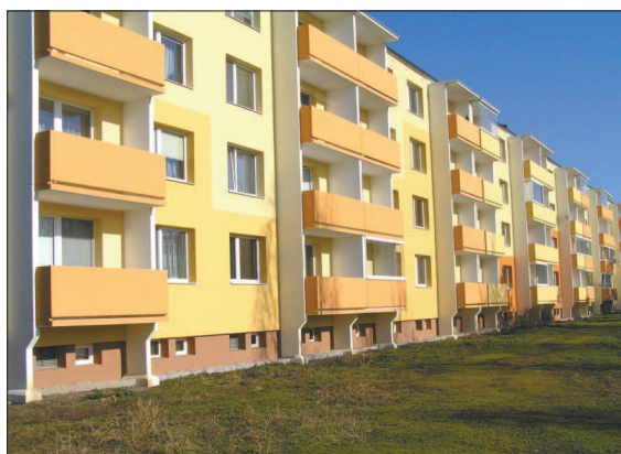
Zadní část bytového domu - nový stav
