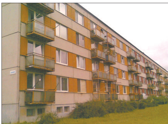
Zadní část bytového domu - původní stav
