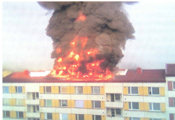
Obr. 2 - požár bytového jádra ve 4. NP se instalační šachtou rozšířil až do 7. NP a zachvátil kromě dalších bytů i střechu
