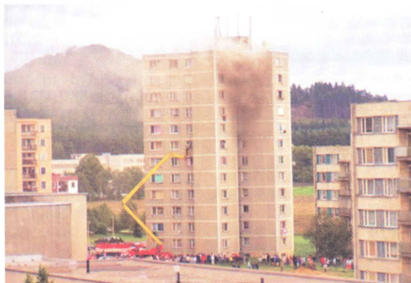
Obr. 1 - při požáru elektroinstalací šachty na chodbě zůstali obyvatelé horních šesti pater zcela odříznuti
